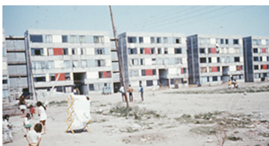
Sector 4: Empresa Constructora Desco Arquitect.: Sergio Larraín, Ignacio Covarrubias Jorge Swinburn.
